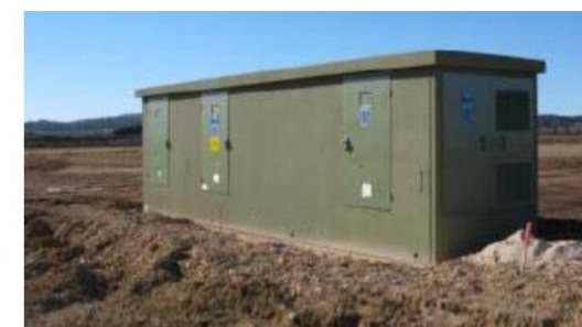
Figure 92 - Exemple de Poste préfabriqué
