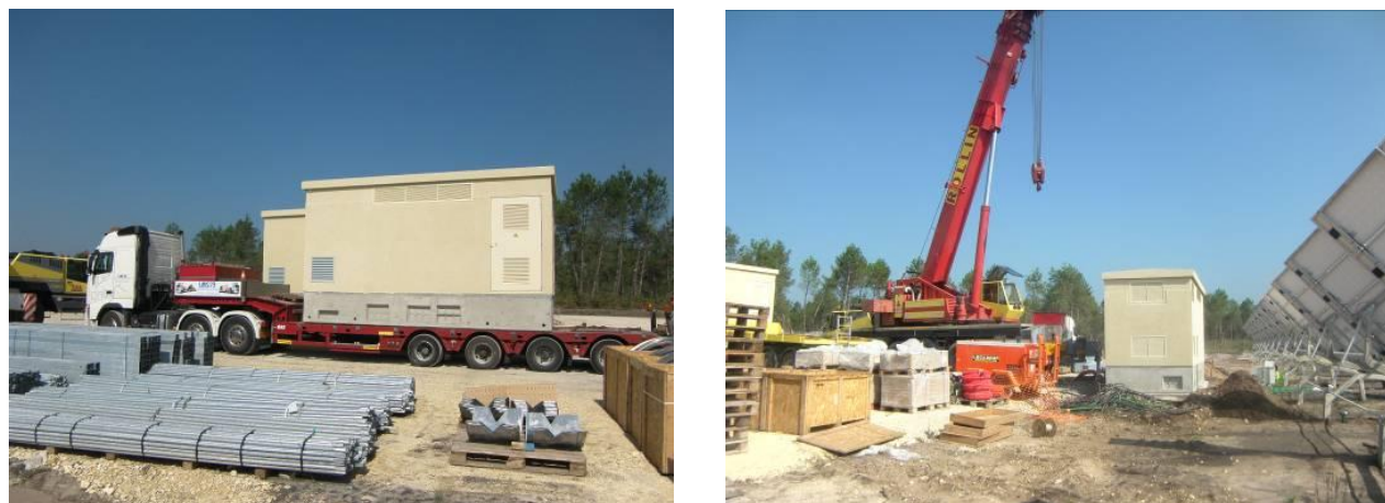
Figure 94 - Installation des onduleurs et du poste de livraison
